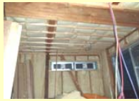
外壁断熱工事の例
