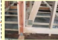
耐震補強工事の例
