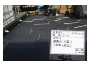
断熱材新設
