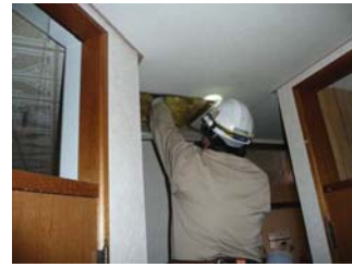
・小屋裏などの確認
