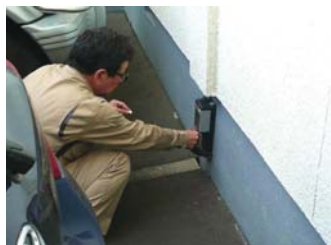
・「鉄筋探査機」による基礎鉄筋の確認
