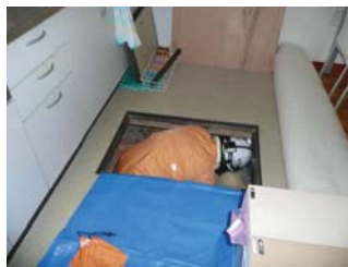
・床下の状況確認
