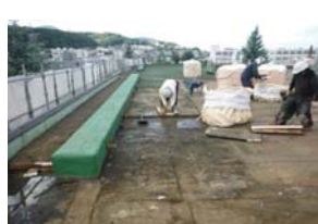
保護砂利・断熱撤去
