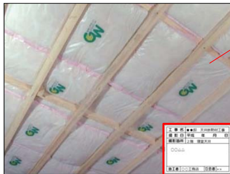
施工後の写真例
